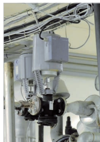
Regulačné ventily Siemens riadia prietok pary do sušičky
