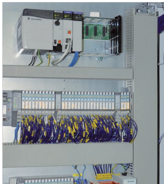
Nový riadiaci systém pre linku Guerin – PLC Allen-Bradley ControlLogix od Rockwell Automation
