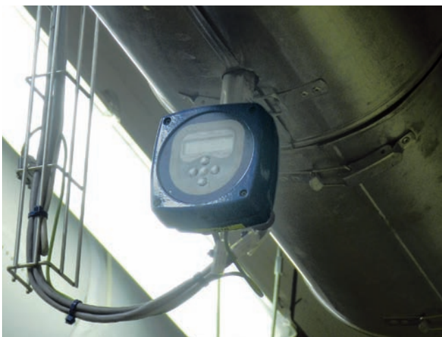
Parokondenzátny systém je pod kontrolou snímačov Spirax Sarco.
